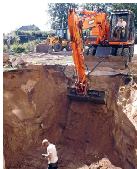
Spätsommer 2016: Die Umbauarbeiten beginnen mit dem Ausheben der Baugrube
