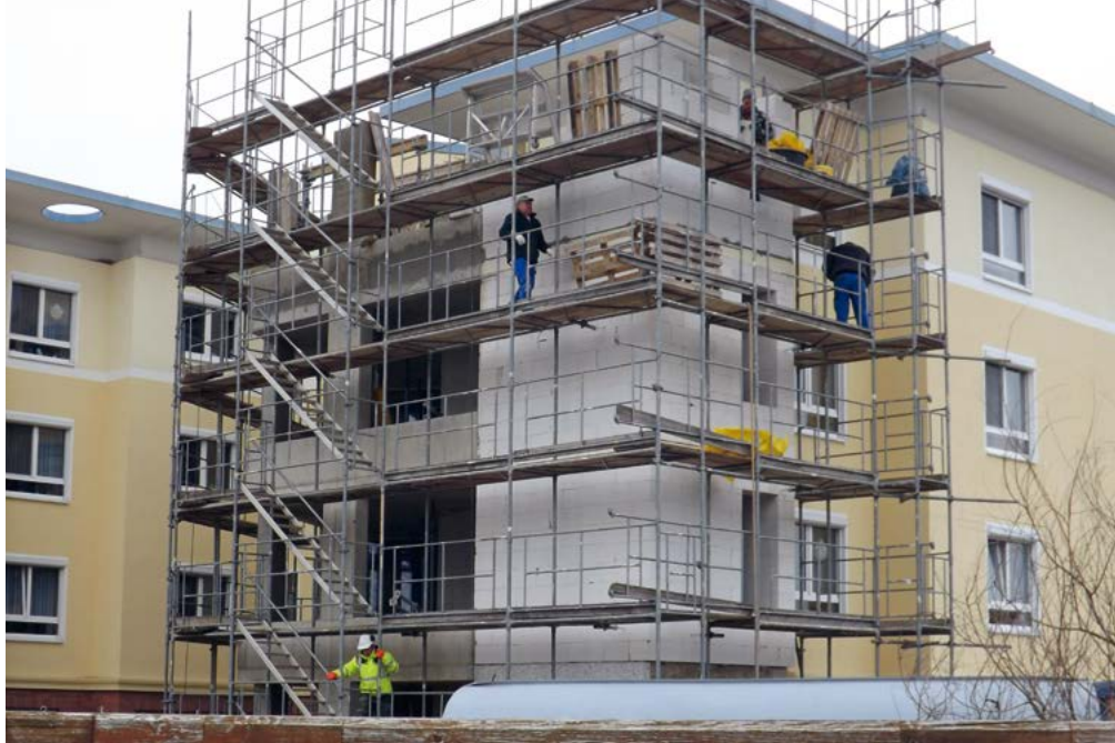
Winter 2016/2017: Die Handwerker arbeiten fleißig an der Fertigstellung des Rohbaus
